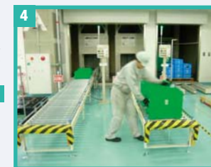
部品の階間移動に用いるリフター
