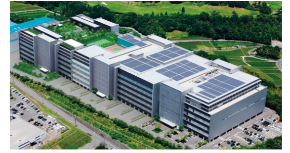
太陽光発電システム(桑畑工場)
